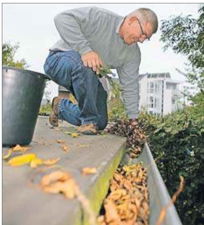
Eine regelmäßige Wartung der Dächer ist das A und O - im Herbst müssen auch die Rinnen vom Laub befreit werden.
